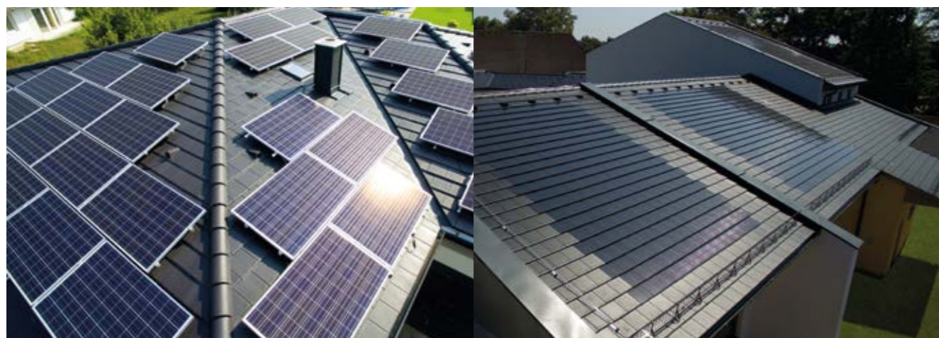
Sistema solare con pannelli grandi
